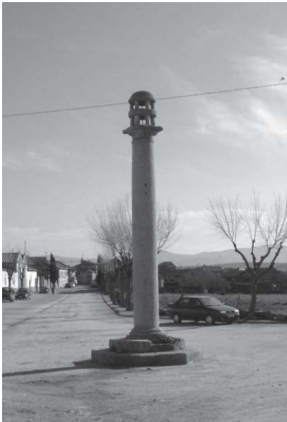
Estado inicial del Rollo.
